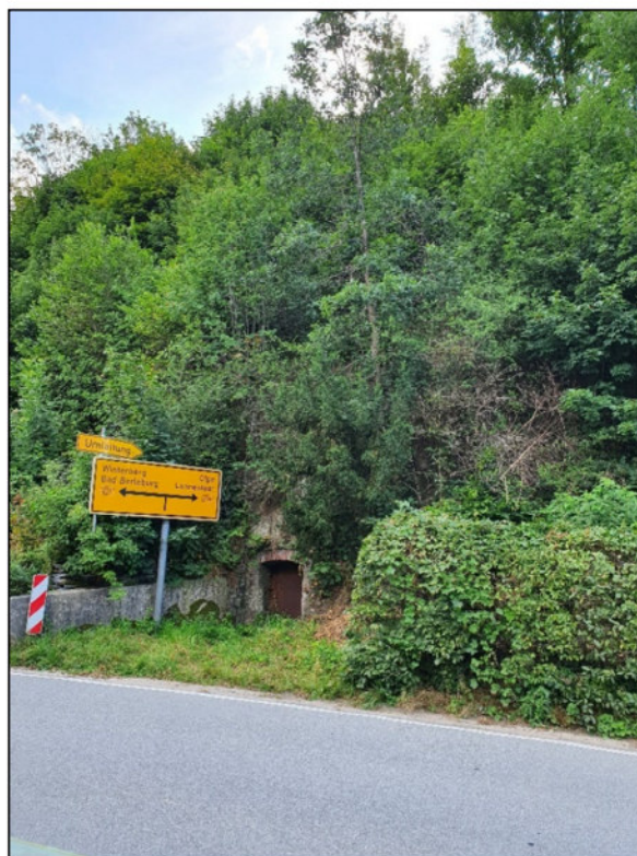
Abb. 2: Mundloch der TÖB 3456/5669/001 westlich der Lennestraße
