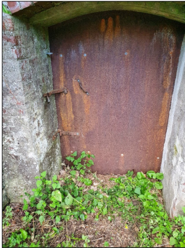
Abb. 4: Durch eine Stahltür und zwei Schlösser gesichertes Stollenmundloch
