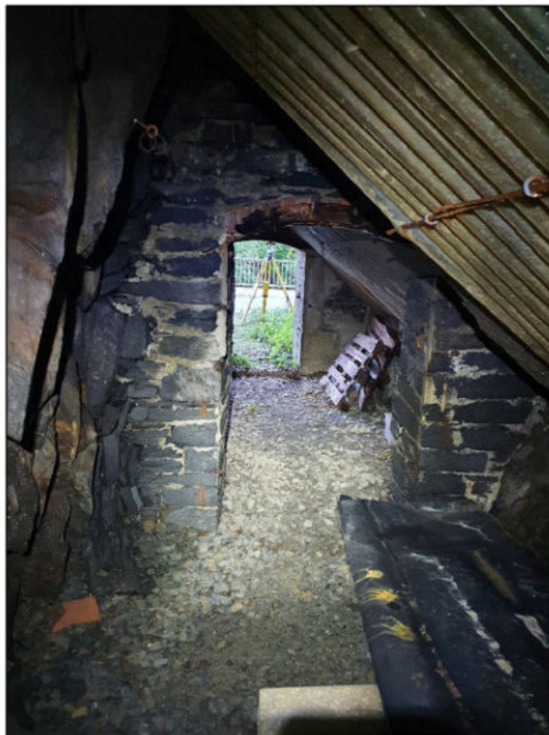
Abb. 6: Tropfschutz und Mauerung
