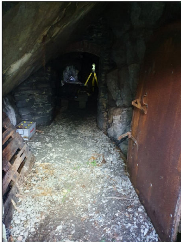
Abb. 8: in Richtung Süden einfallende Gesteinsschichten der Firste
