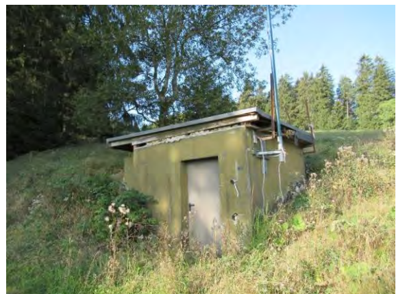
Abb. 10 Brunnen im Plangebiet. Er befindet sich an der Grünland-Forstkante in der Nähe des Skiliftes.
