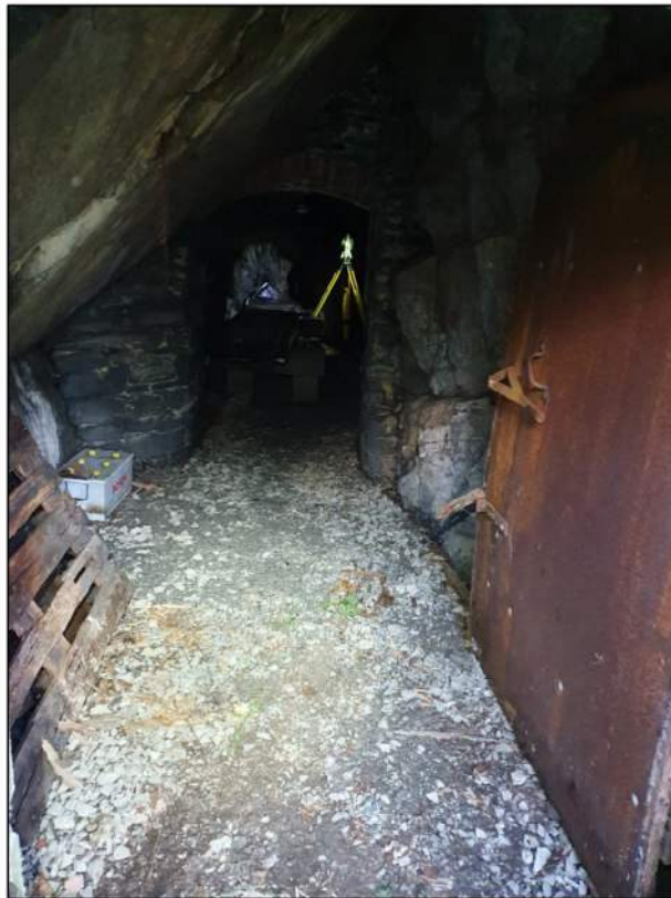
Abb. 8: in Richtung Süden einfallende Gesteinsschichten der Firste
