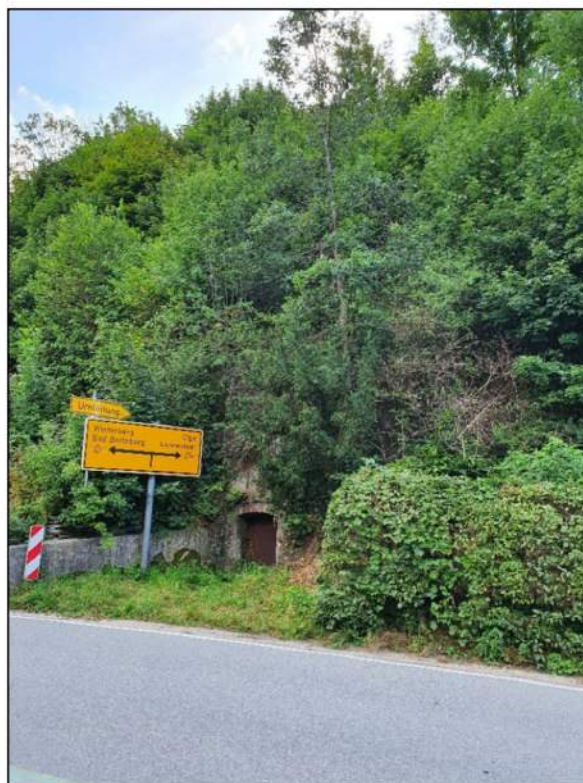
Abb. 2: Mundloch der TÖB 3456/5669/001 westlich der Lennestraße
