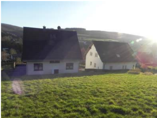
Abb. 6 Westlich angrenzende Wohnbebauung.
