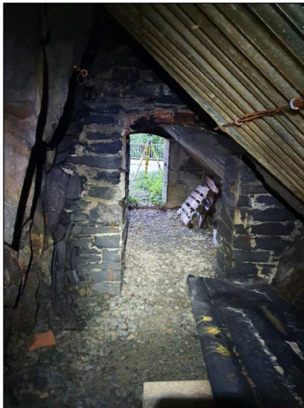
Abb. 6: Tropfschutz und Mauerung
