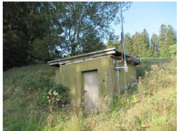
Abb. 11 Brunnen im Plangebiet. Er befindet sich an der Grünland-Forstkante in der Nähe des Skiliftes.
