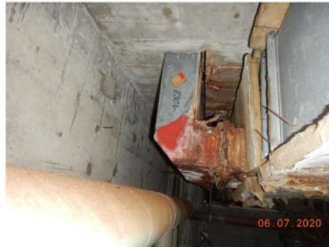
Korrodierte Lüftungskanäle
