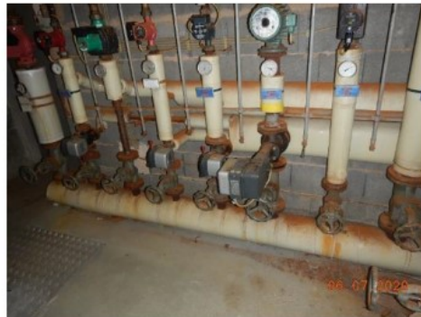
Alter Heizungsverteiler
