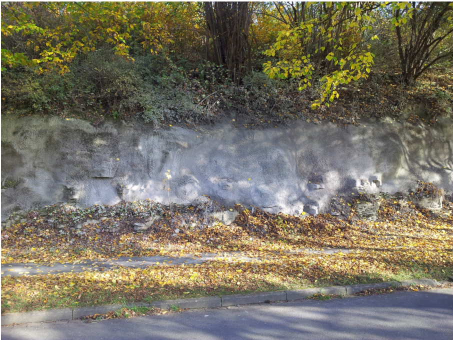
Beispiel: Rückverankerte Spritzbeonschale
