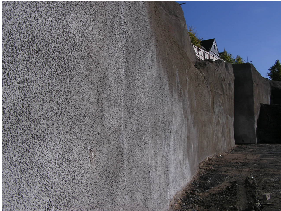
Beispiel: Rückverankerte Spritzbeonschale
