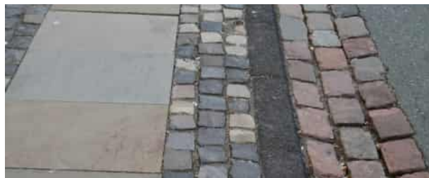
Abb. 17: Rollbereich und Übergang zur Fahrbahn (Bestand, Ost- und Weststraße)
