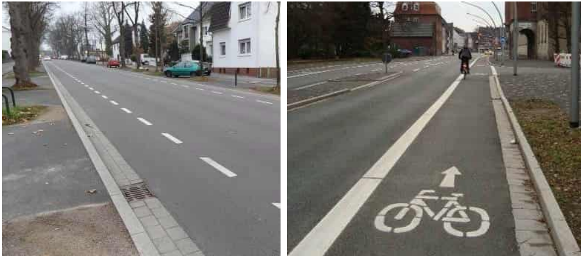
Abb. 29: Radverkehrsführung auf der Fahrbahn: Schutzstreifen (links) und Radfahrstreifen (rechts)
