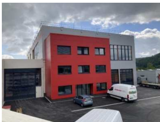
Abb. 12 Neues Gebäude im Plangebiet.
