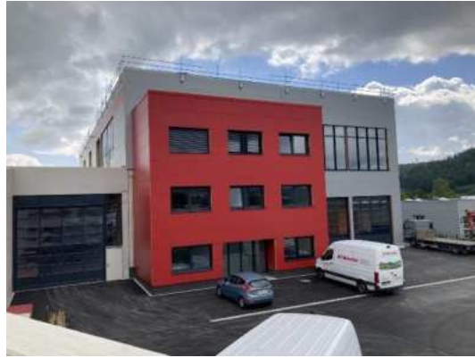
Abb. 8 Neues Gebäude im Plangebiet.
