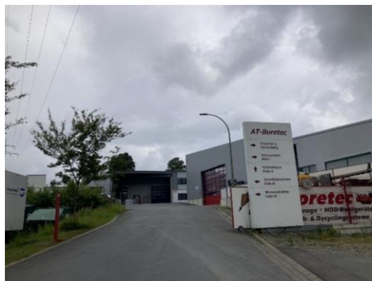
Abb. 14 Zufahrt zum Betriebsgelände aus südlicher Richtung.
