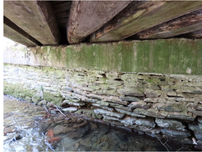
Natursteinwiderlager mit Auflagerbalken
