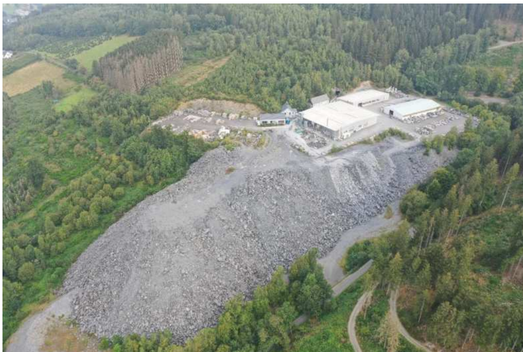
Abb. 11 Drohnenaufnahme der Schiefergrube Magog aus südöstlicher Richtung.
