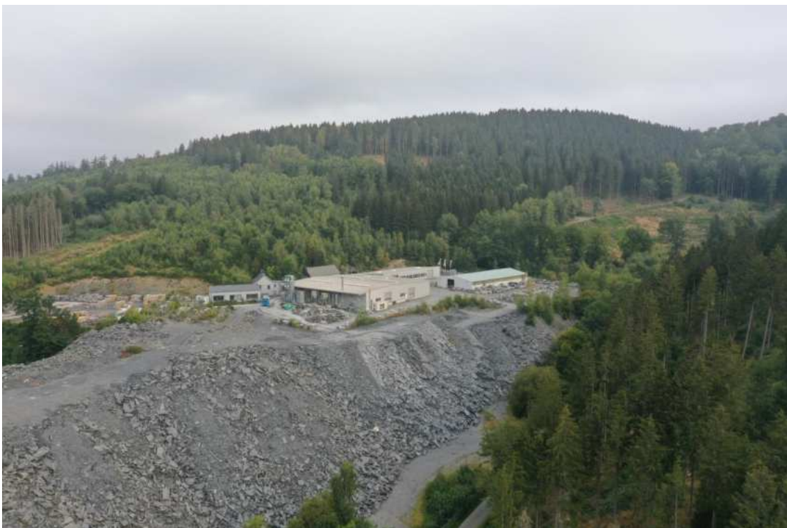
Abb. 20 Blick von Norden in nordwestliche Richtung über das Plangebiet.
