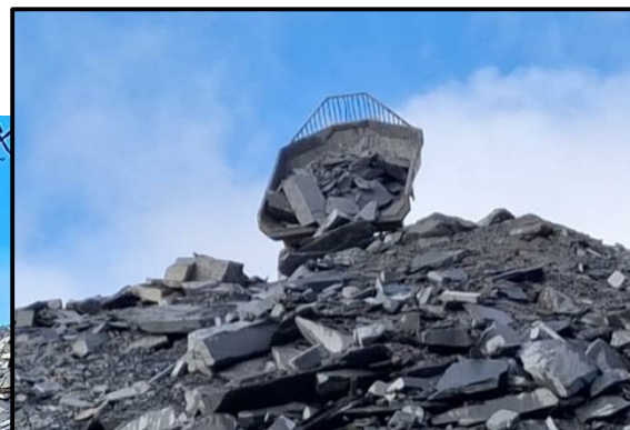
Abb.6: Abwurf mit Dumper an Haldenoberkante
