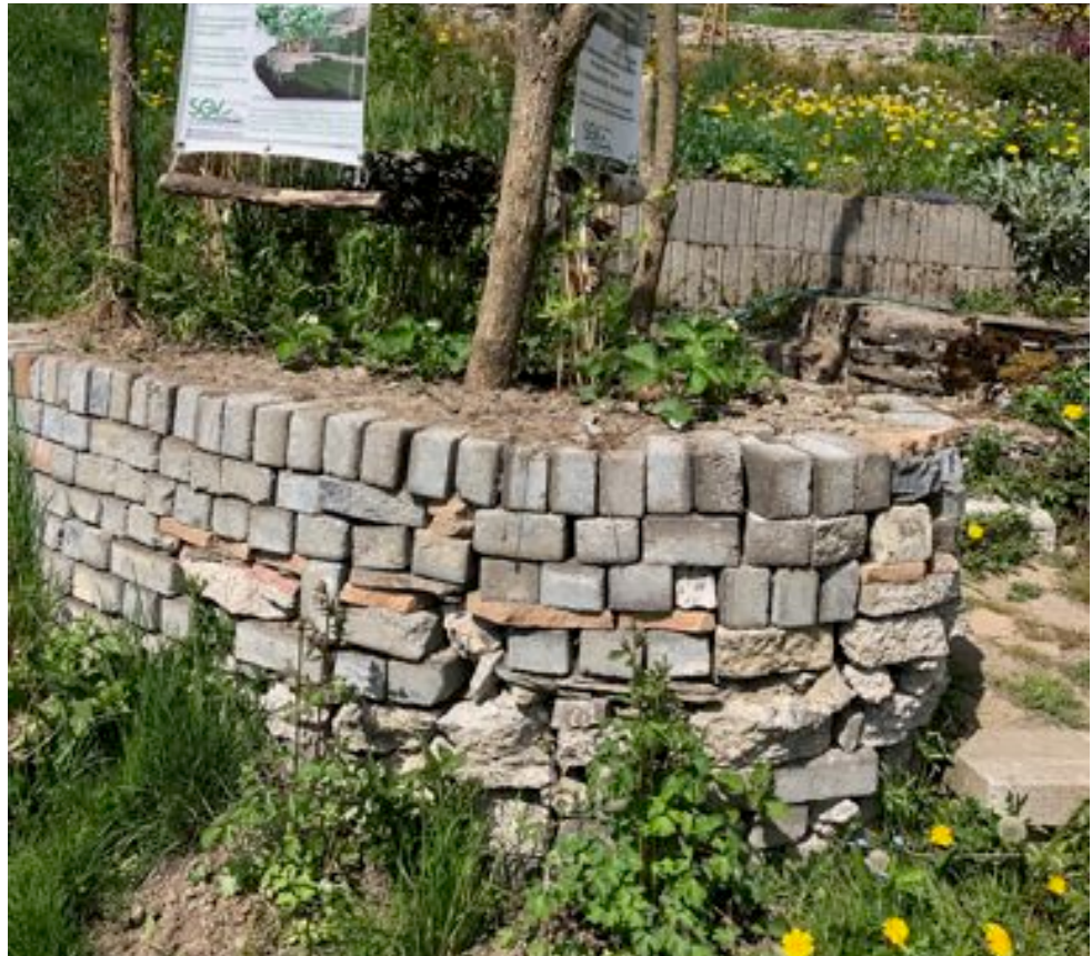
Bestehende Betonstein- mauer
